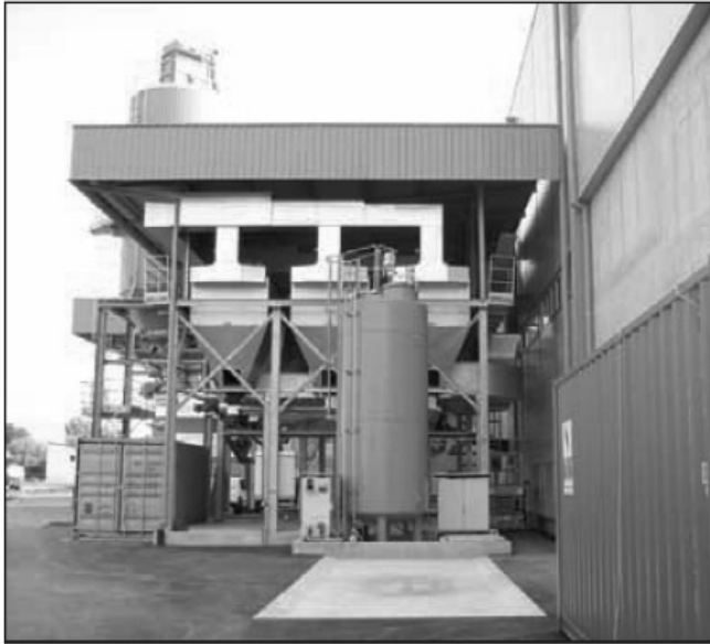
Слика 6.27. Опрема за пречишћавање отпадних гасова
