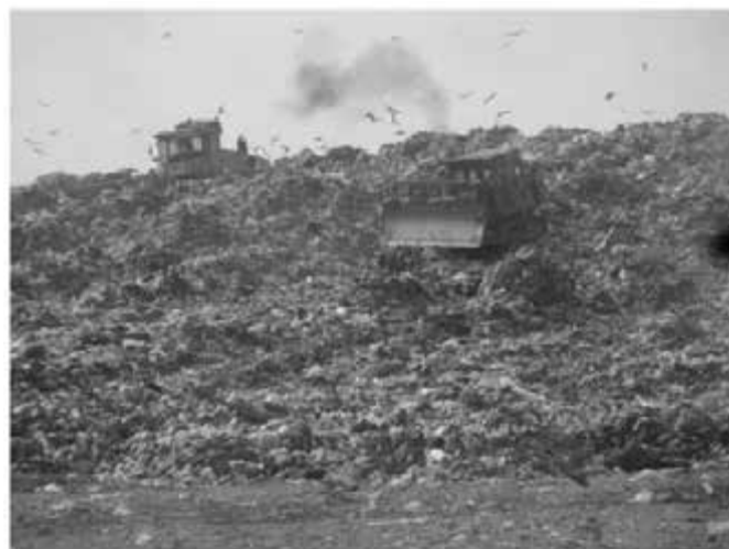
Слика 4.9. Сабијање отпада врши се свакодневно на депонији у Винчи
