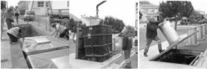
Слика 6.5. Подземни контејнери са пражњењем са дизалицом
