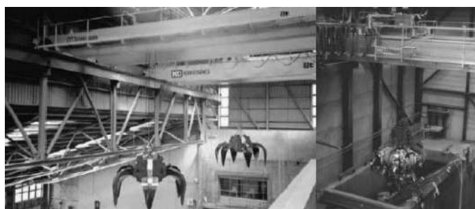
Слика 6.26. Изглед крана са граблицом за отпад
