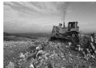
Слика 4.20. Сабијање отпада врши се свакодневно на депонији у Винчи
