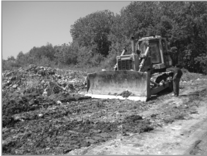
Слика 8. Постојећа депонија комуналног отпада у Барошевцу
