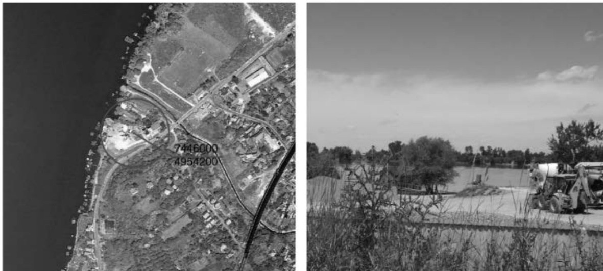
Слика 49: локација БАНБУС БЕТОН
